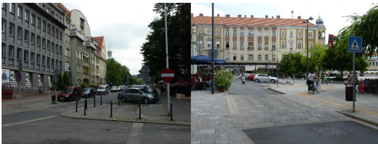
19. ábra: Forgalmcsillapítási megoldások: szűkítés, gyalogátkelő kiemelése (Katowice / Szombathely)
